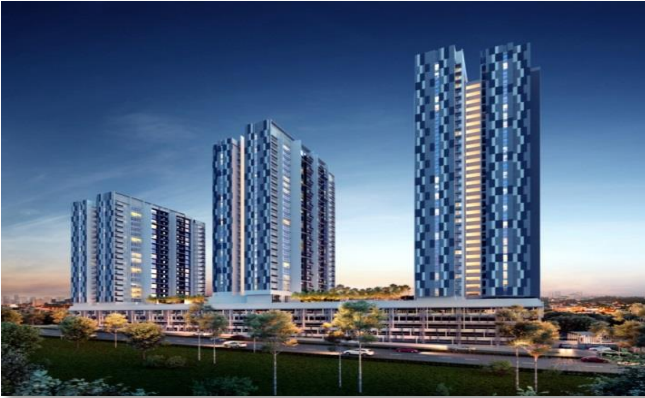
Kajang Utama Project, Selangor
